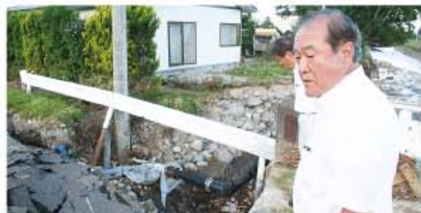
2013.8.12 集中豪雨被害視察 雫石町
